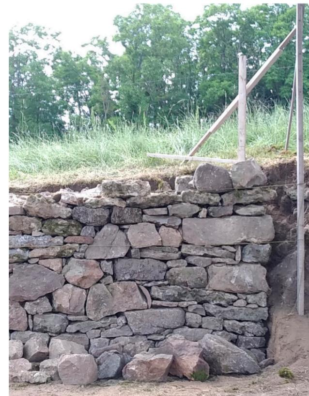
Réfection d'un mur de soutènement en pierre sèche. Réalisation d'une portion de «mur témoin» dans le cadre d'un stage d'initiation organisé par le PNR du Morvan en 2023.
