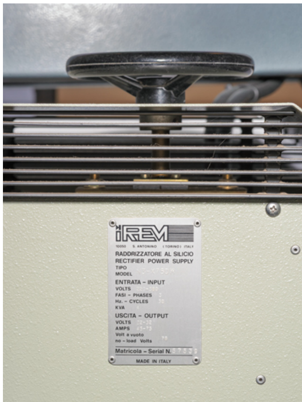
Plaque signalétique du redresseur IREM.
