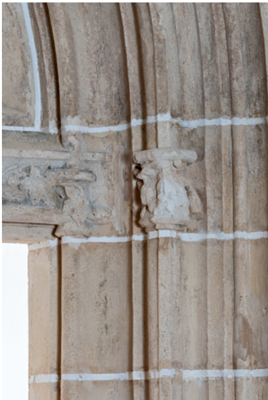
Détail : piédroit, partie supérieure.
