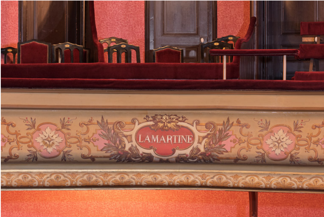
Garde-corps du 1er balcon (Lamartine).
