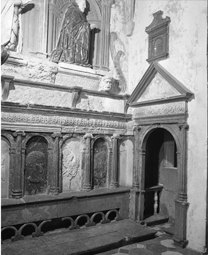
Façade ouest de la chapelle.
