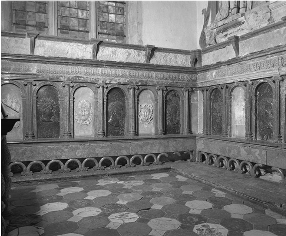
Façades sud et ouest de la chapelle.
