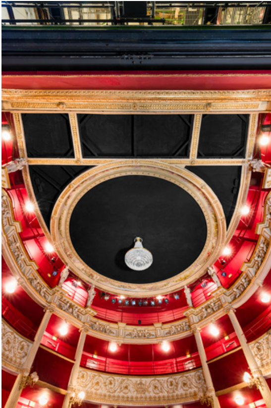
Vue d'ensemble du plafond.
