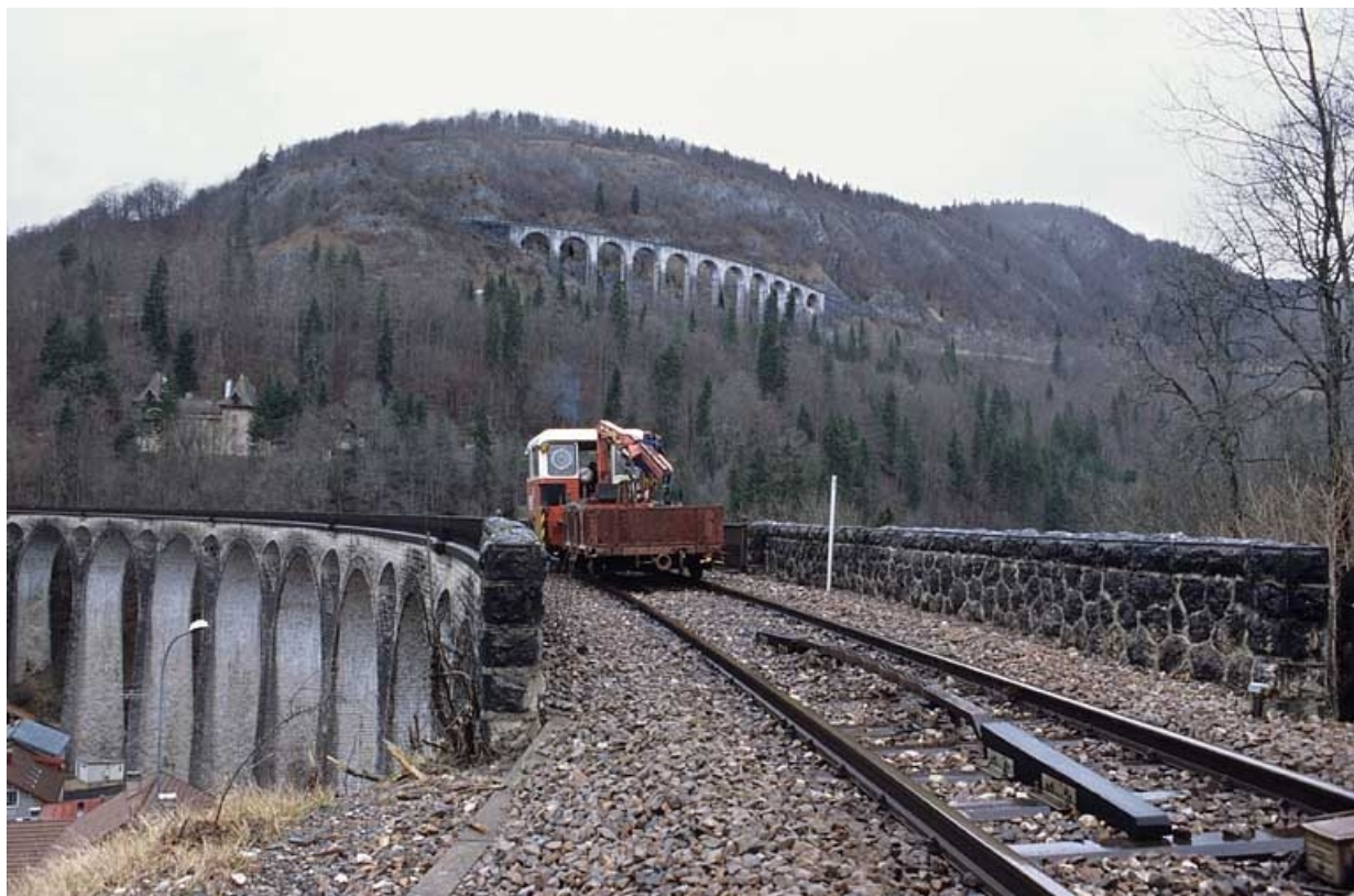
Draisine sur le viaduc de Morez.
