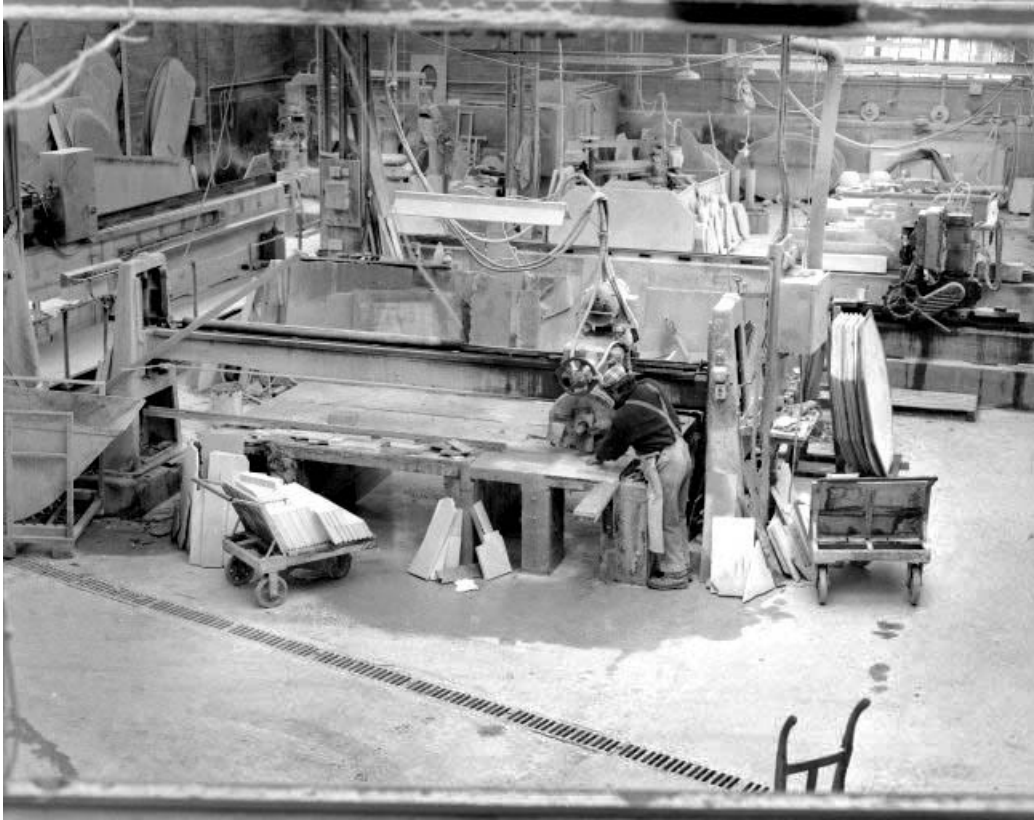
Débiteuse nord : vue d'ensemble plongeante.
