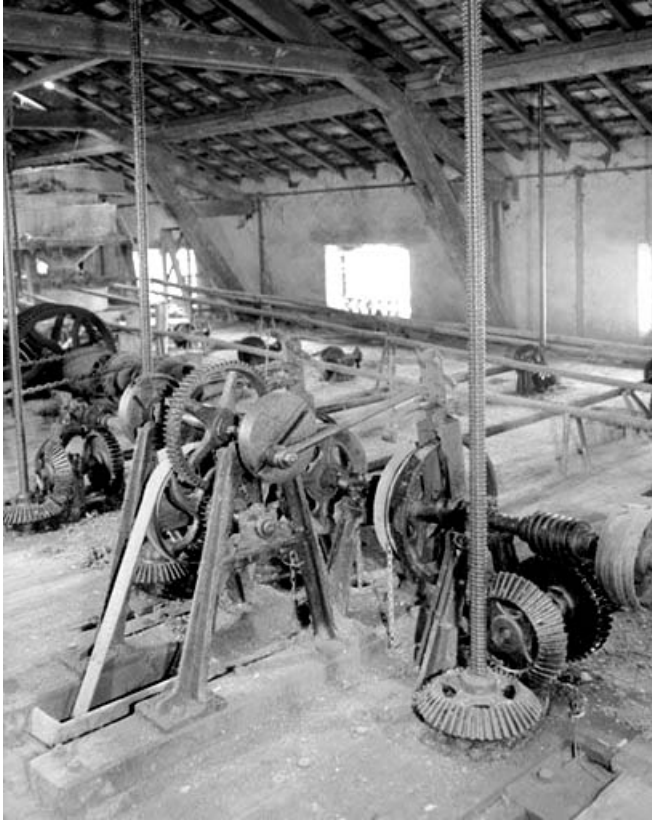
Système de descente à vis : détail.
