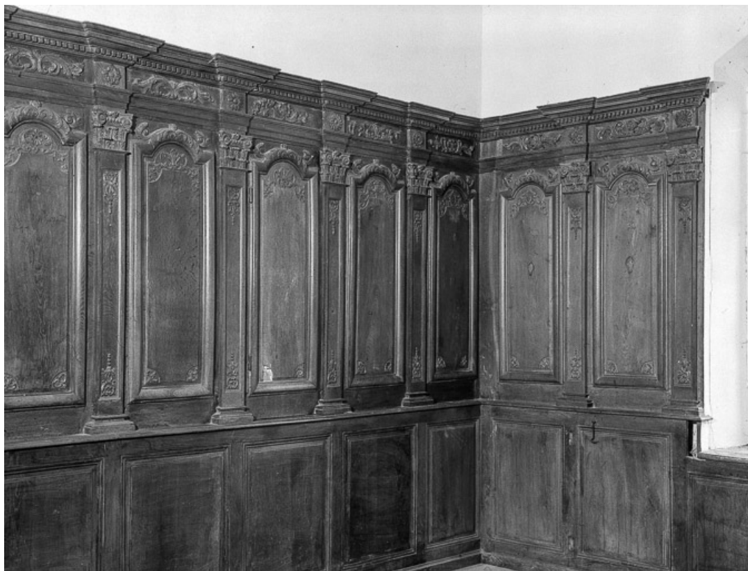
Lambris du mur est de la sacristie.
