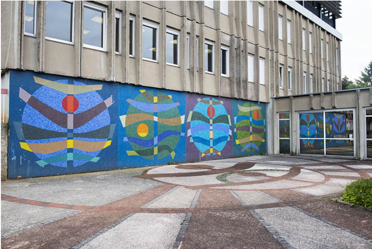
Détail façade, sol et mosaïque de l'externat.
