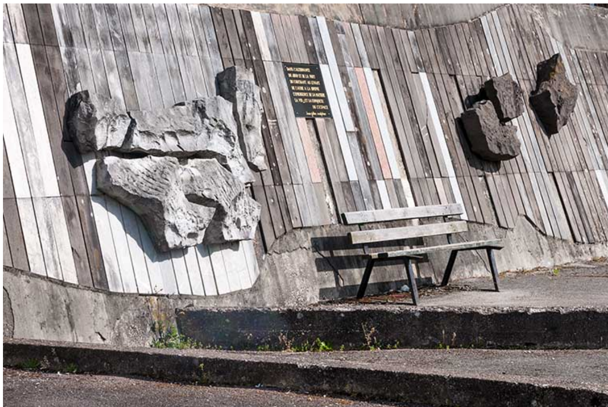
Vue de détail, depuis l'ouest.
