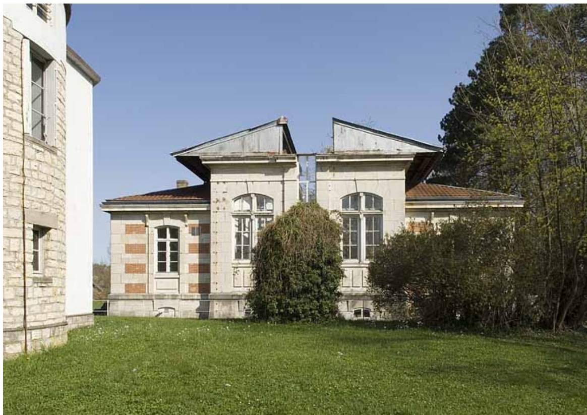
Elévation sud du pavillon, toiture ouverte.
