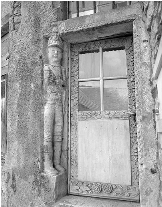
Porte d'entrée vue de trois quart droit.
