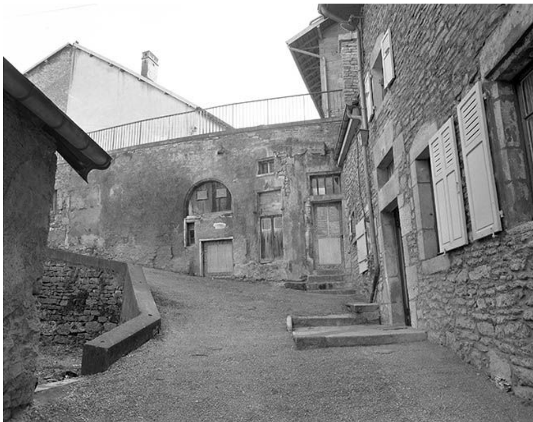
Vue d'ensemble des élévations rue du Charri.
