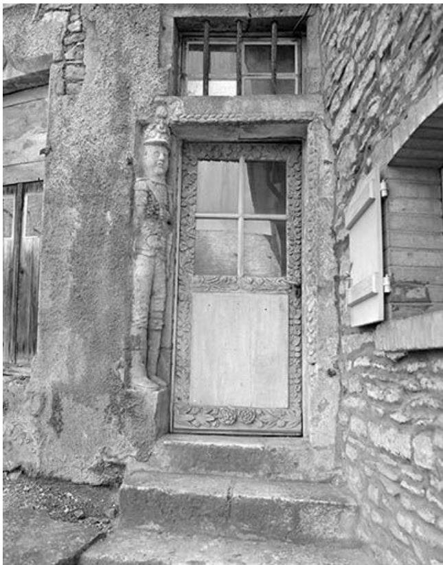
Porte d'entrée vue de face.
