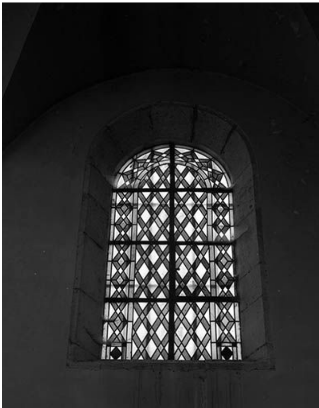
Vue générale de la baie n° 101.
