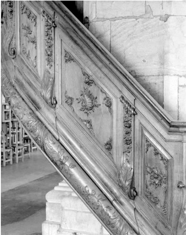
Détail : panneau de la rampe.
