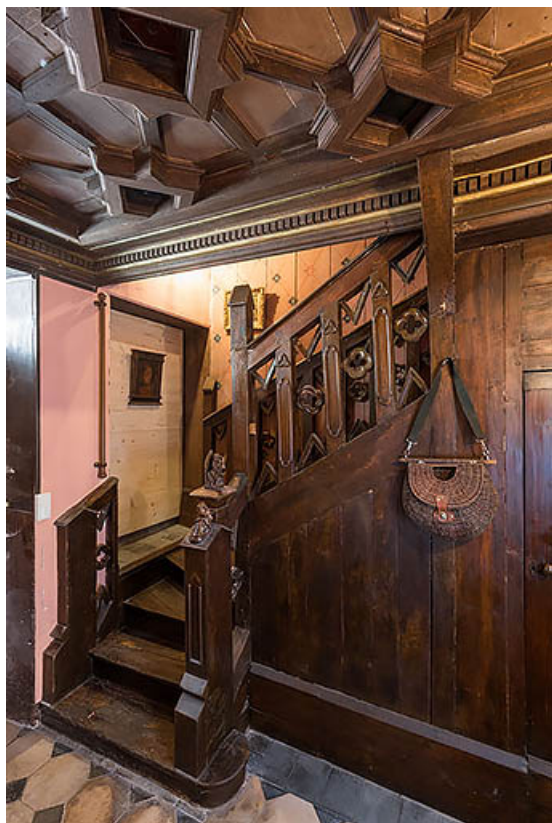
Vue d'ensemble au rez-de-chaussée.
