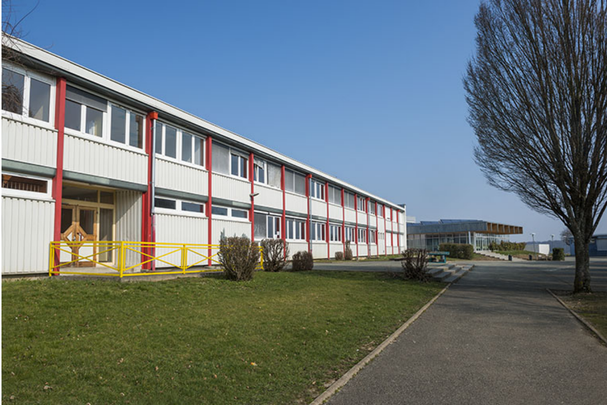
Façade sud de l'externat sud.
