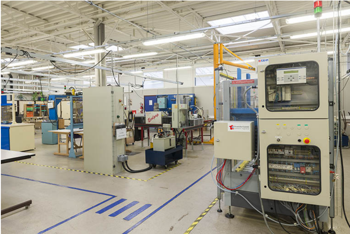
Vue intérieure d'un atelier.
