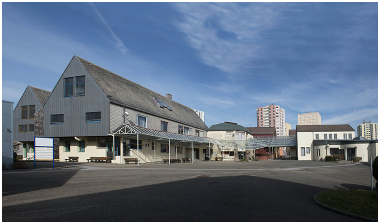
La place vue de l'ouest.
