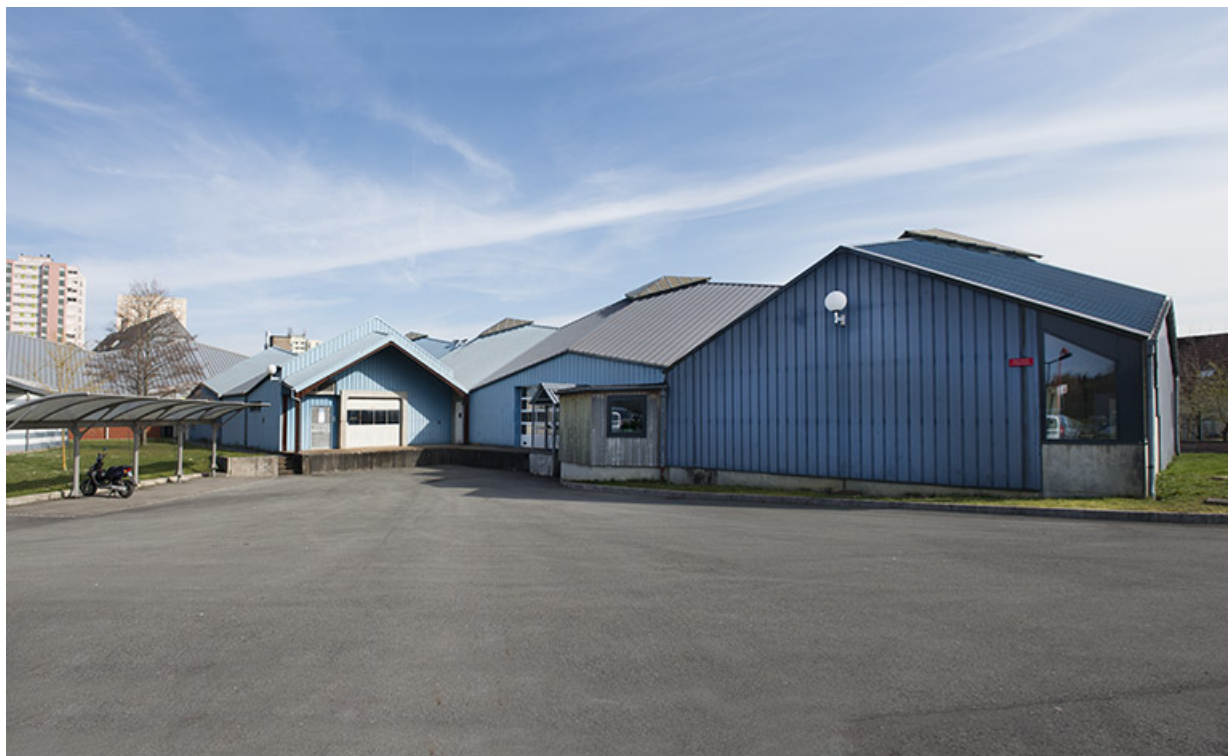
Façades postérieures ouest des ateliers de mécanique.
