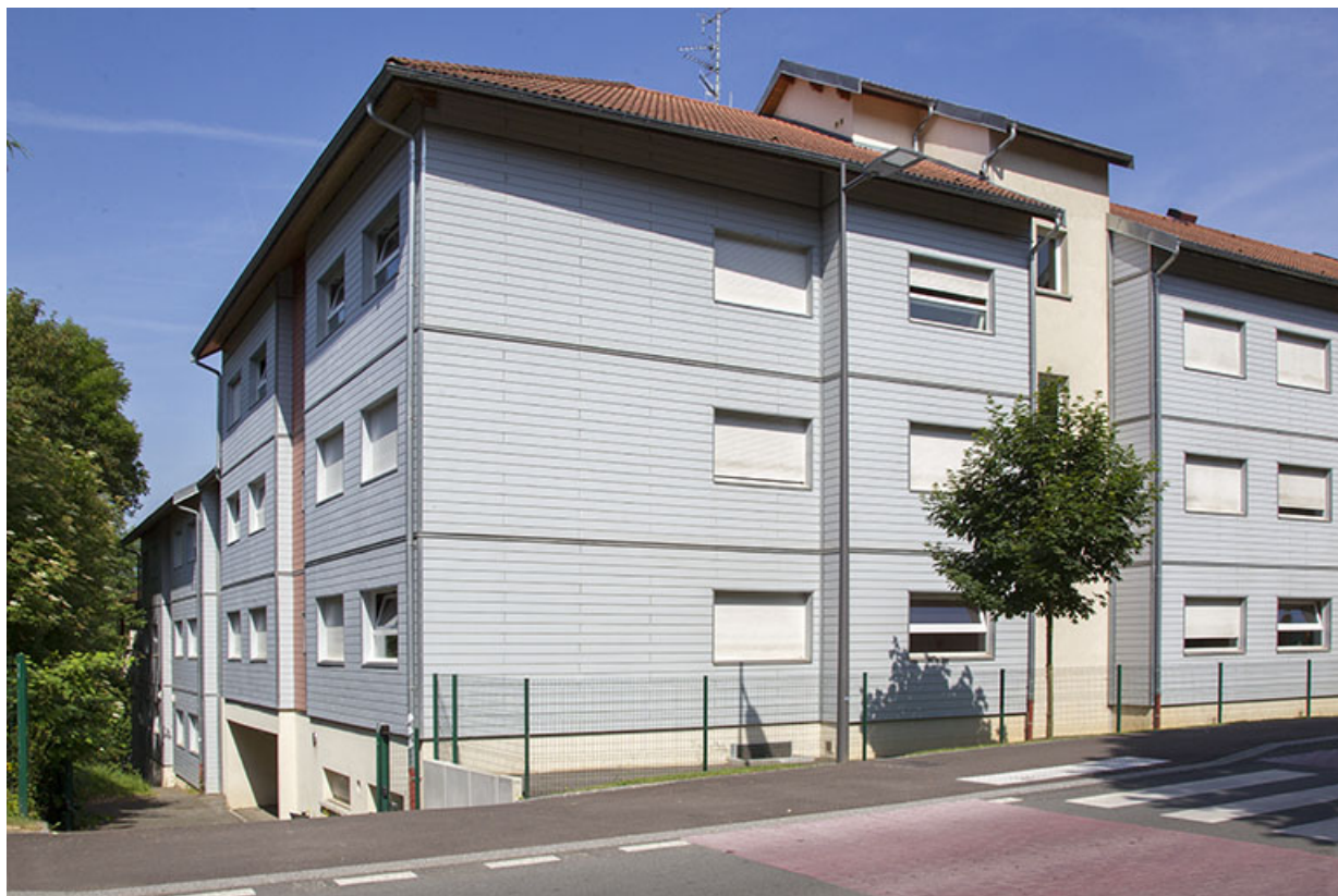
Pignon sud de l'internat, angle sud-est.
