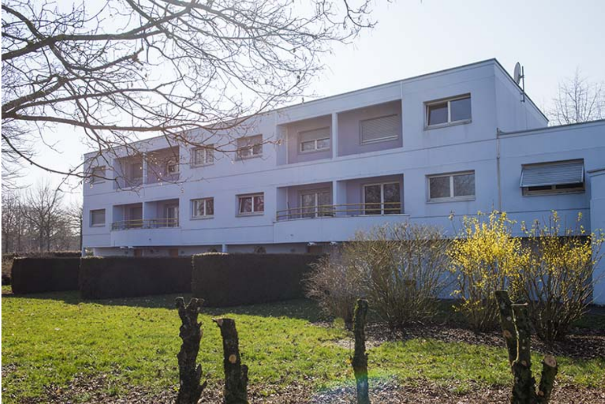
Façade postérieure est des logements sud-ouest.
