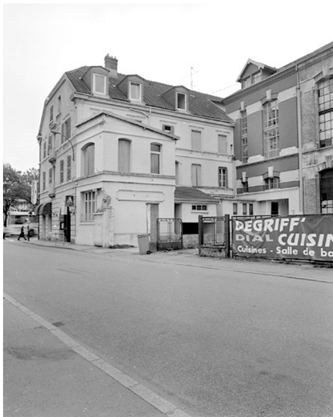
Bureau et façade de l'atelier de fabrication.
