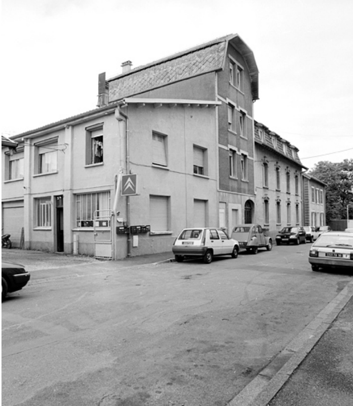
Logement (à gauche).
