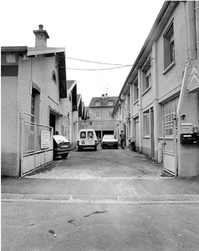
Passage entre l'atelier et le logement.
