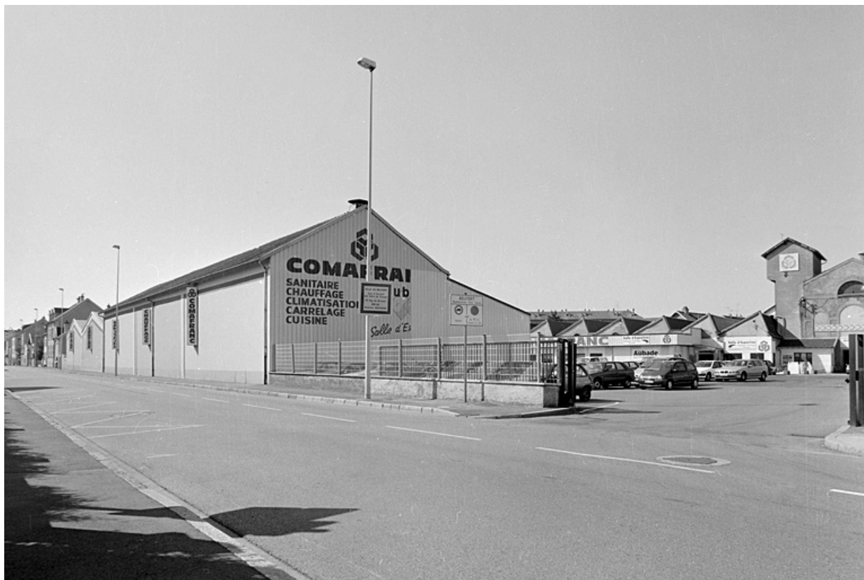
Vue de l'entrée depuis l'avenue Jean Jaurès.
