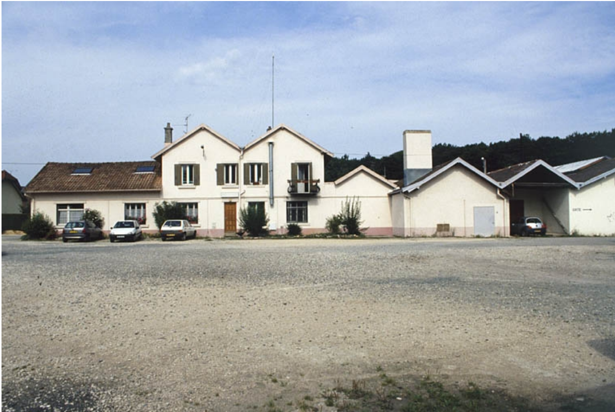
Façade postérieure des bâtiments sur rue.
