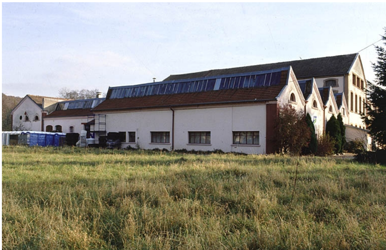
Vue de trois quarts depuis l'ouest.
