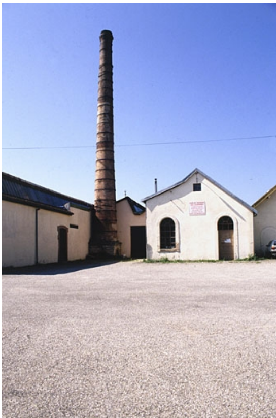
Cheminée et salle des machines.
