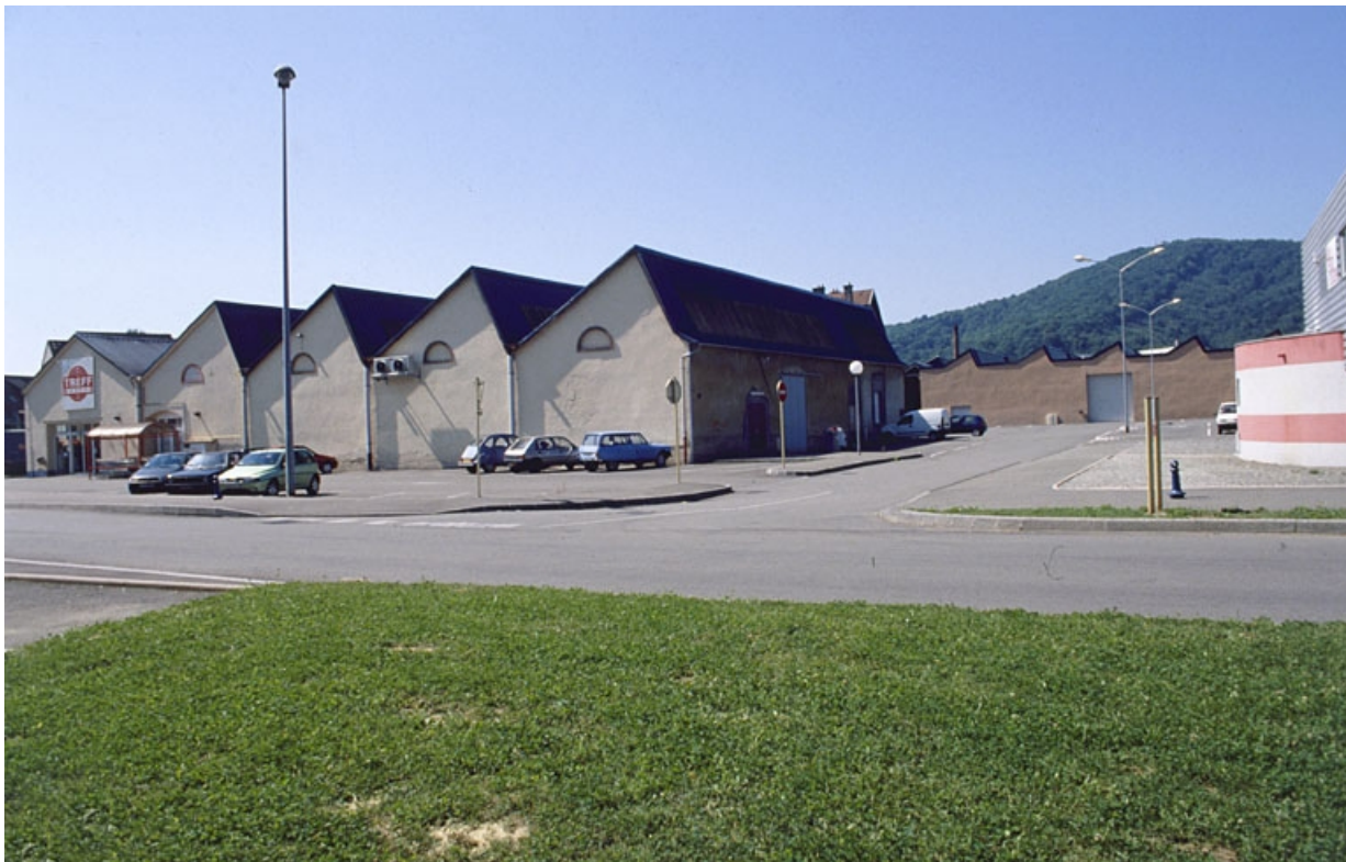
Pignons est d'ateliers (?) couverts de sheds.
