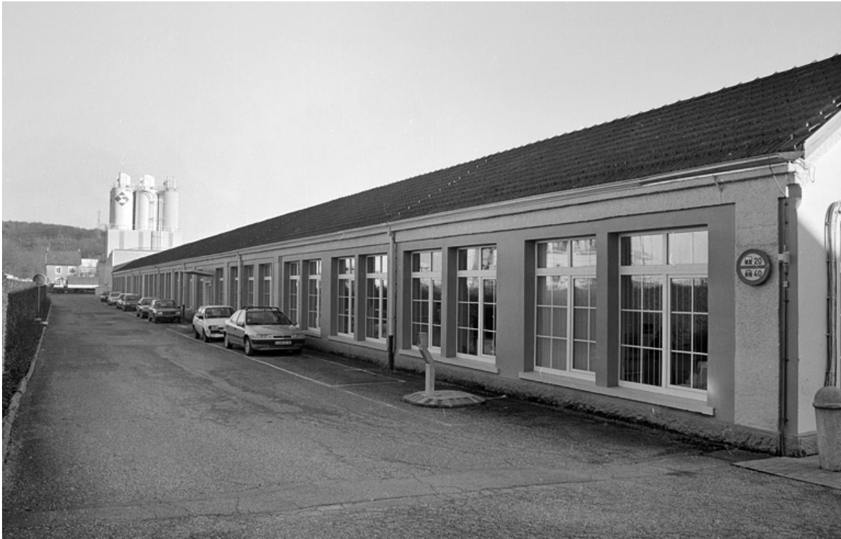
Façade nord de l'atelier de fabrication.
