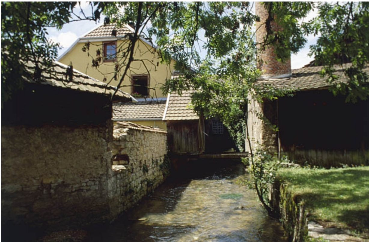
Vue en aval de la Batte.
