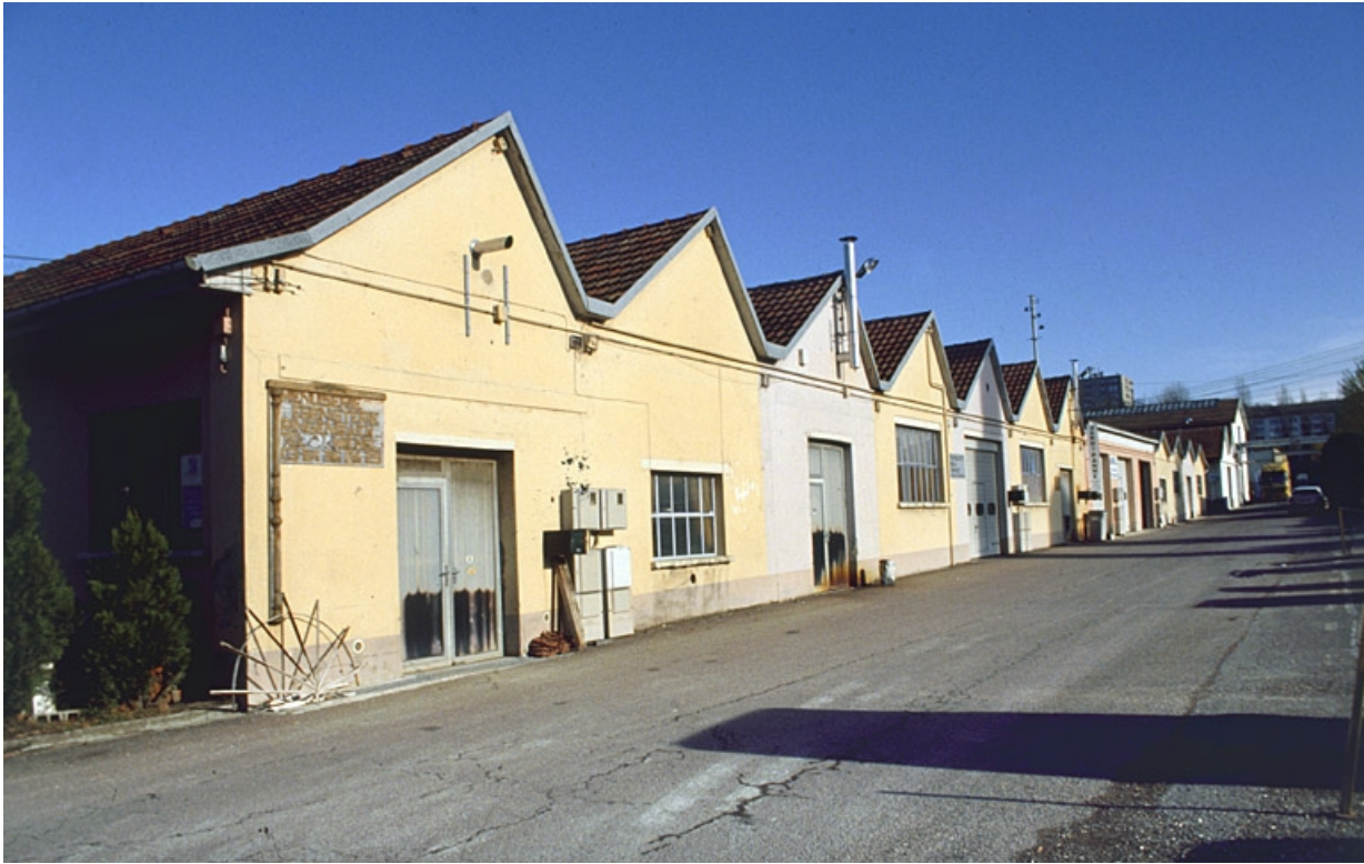
Murs-pignons d'ateliers (forge, menuiserie) et de remises.
