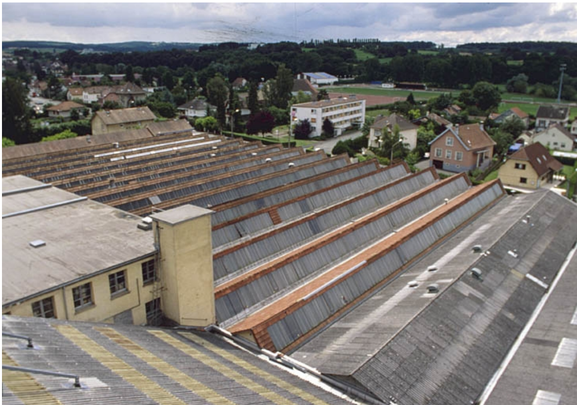
Toitures des ateliers de fabrication en rez-de-chaussée.
