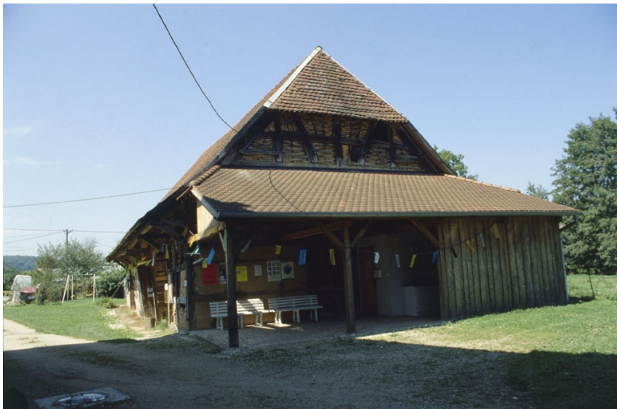
Pignon du bâtiment agricole.
