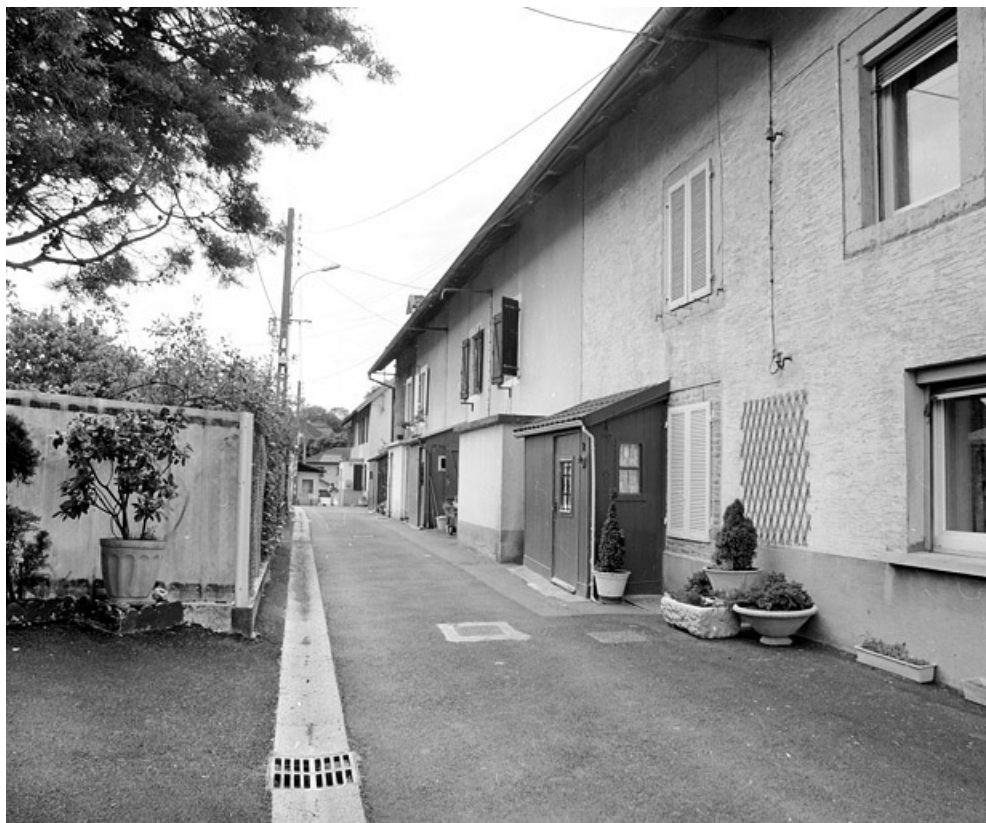
Façades est rue des Bouleaux.
