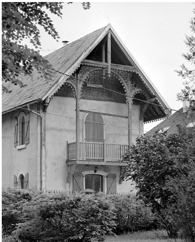
Détail du pignon de la conciergerie.
