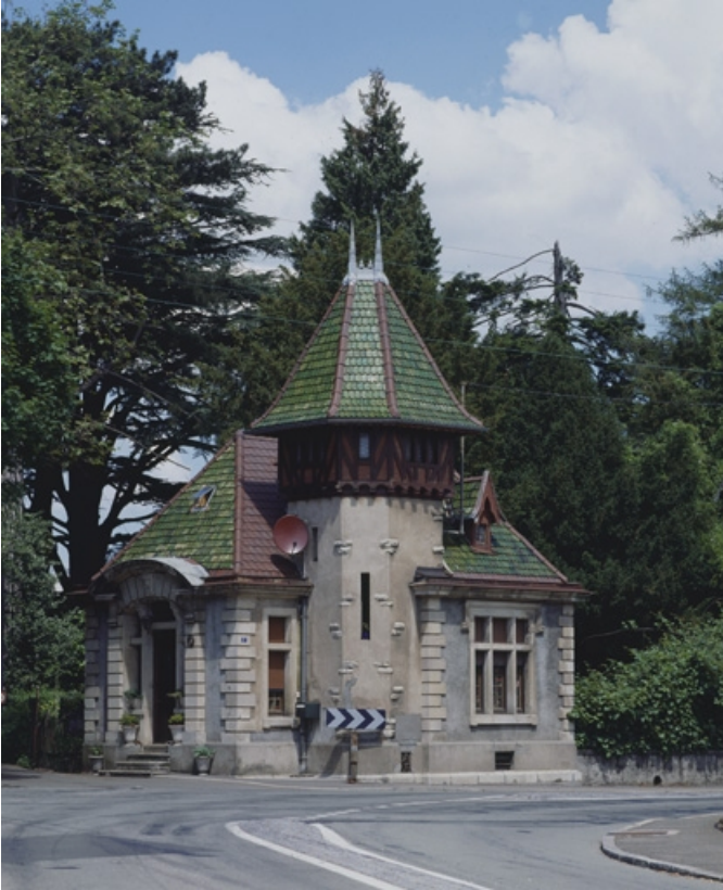
La conciergerie depuis le sud-ouest.
