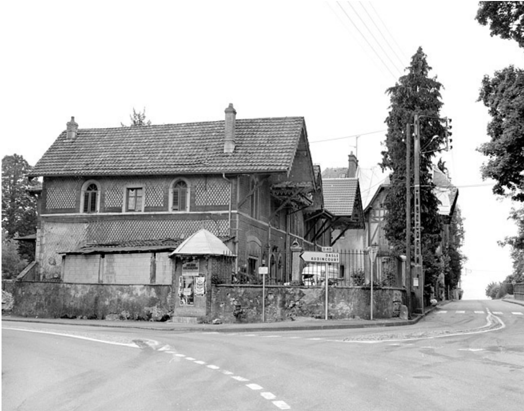
Façade orientale de la ferme.
