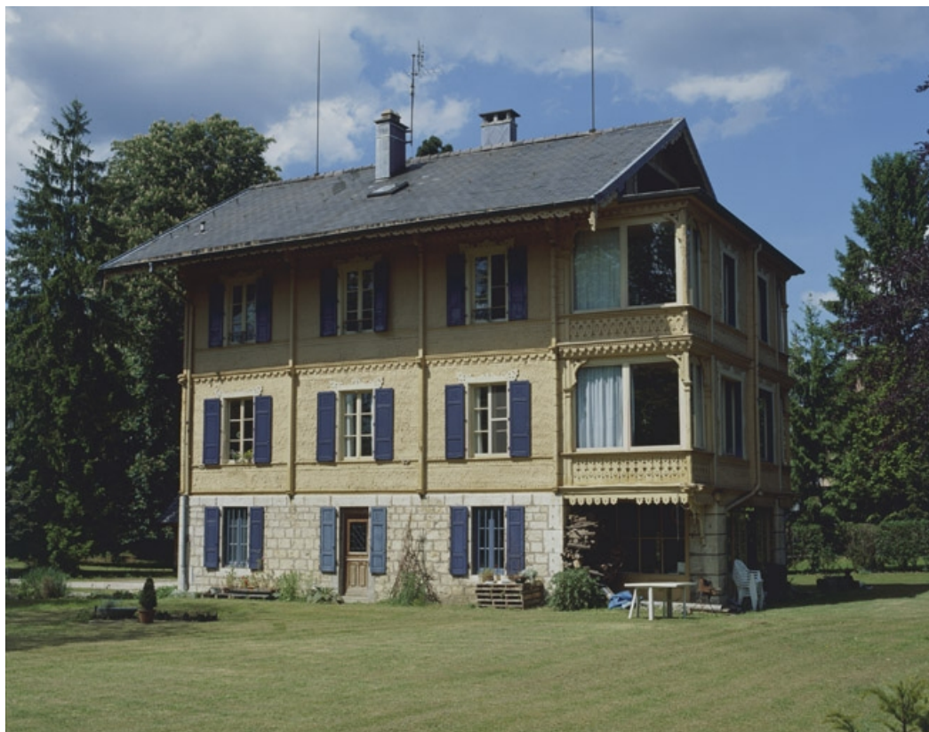
Chalet. Façade sud.
