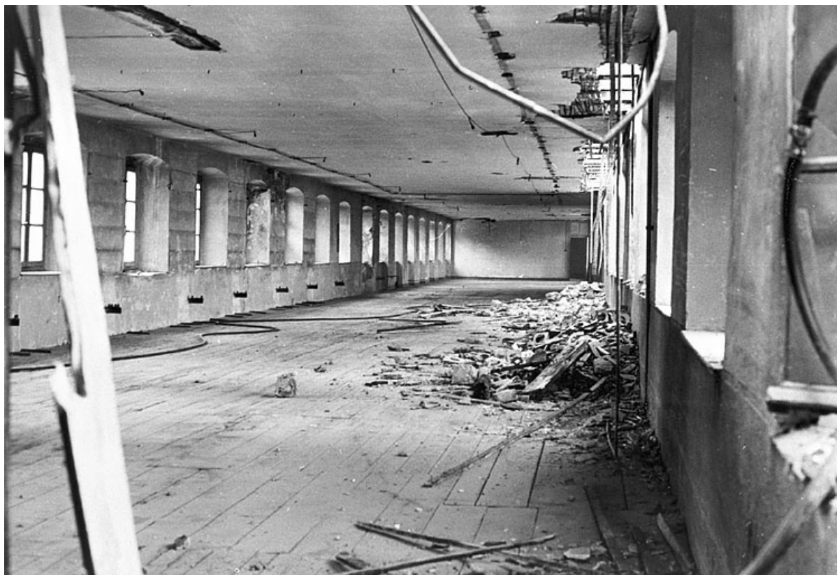
Atelier au second étage (état en 1978).
