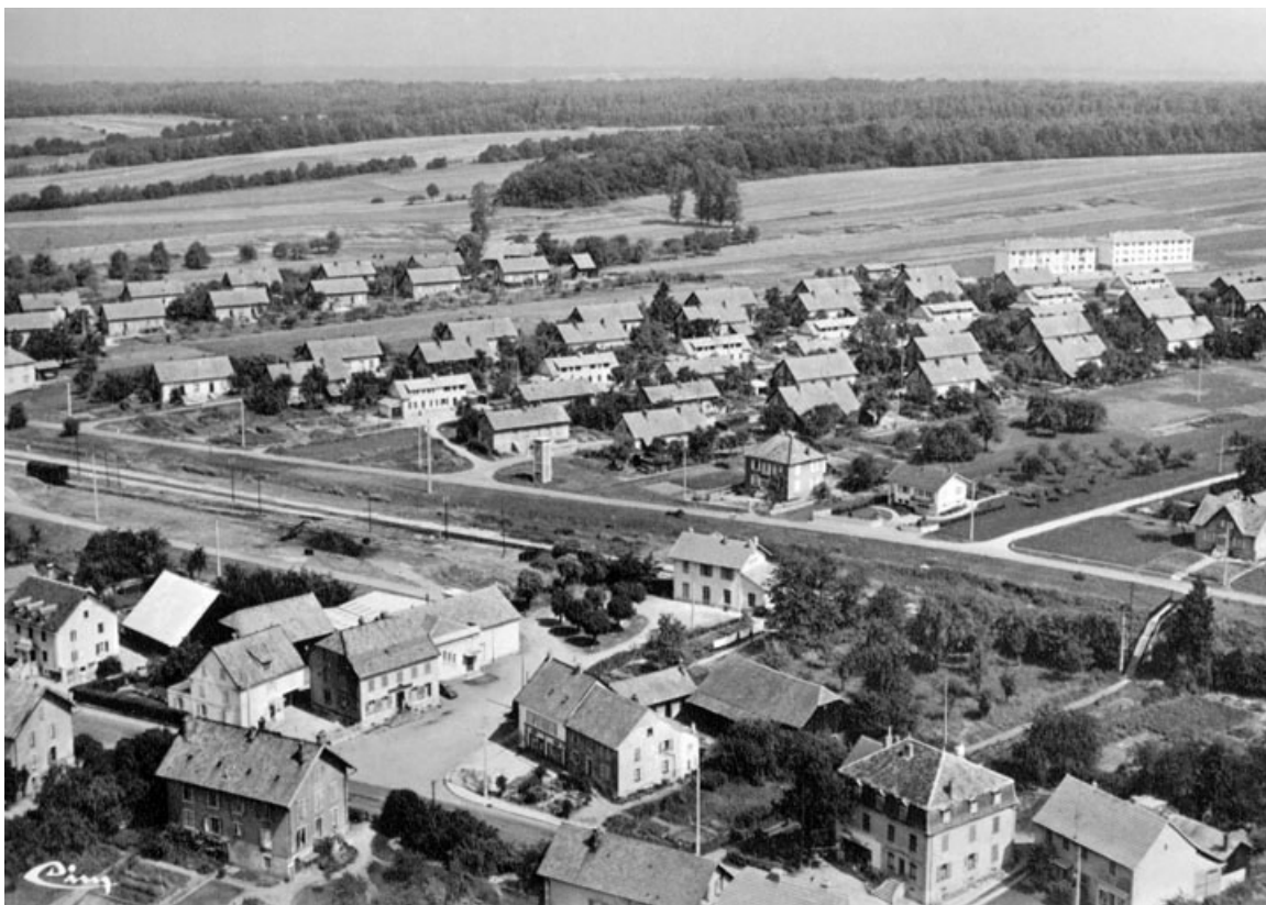
Grandvillars (Ter.-de-Belfort.). Vue générale.
