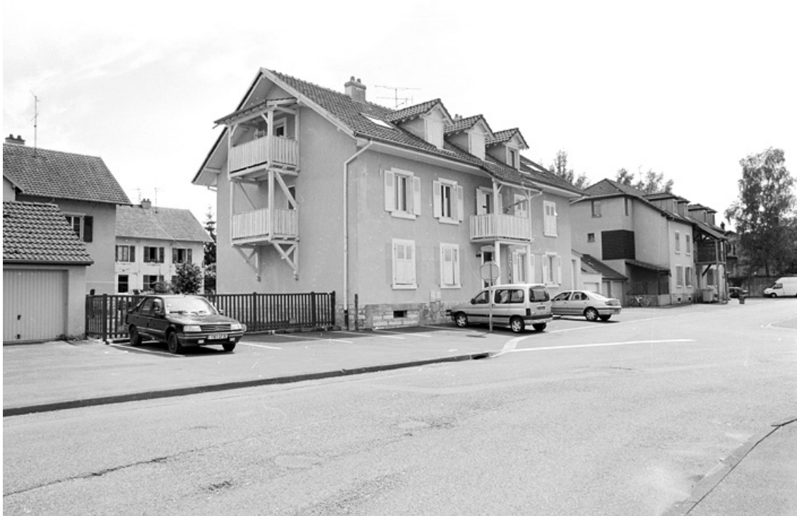
Logements collectifs (1902) rue Kléber.
