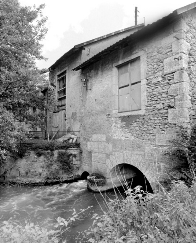
Canal de fuite et bâtiment d'eau.
