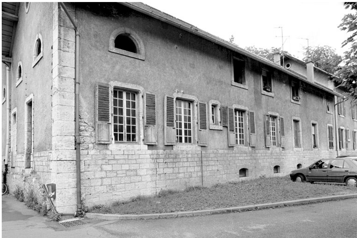
Façade est des écuries.
