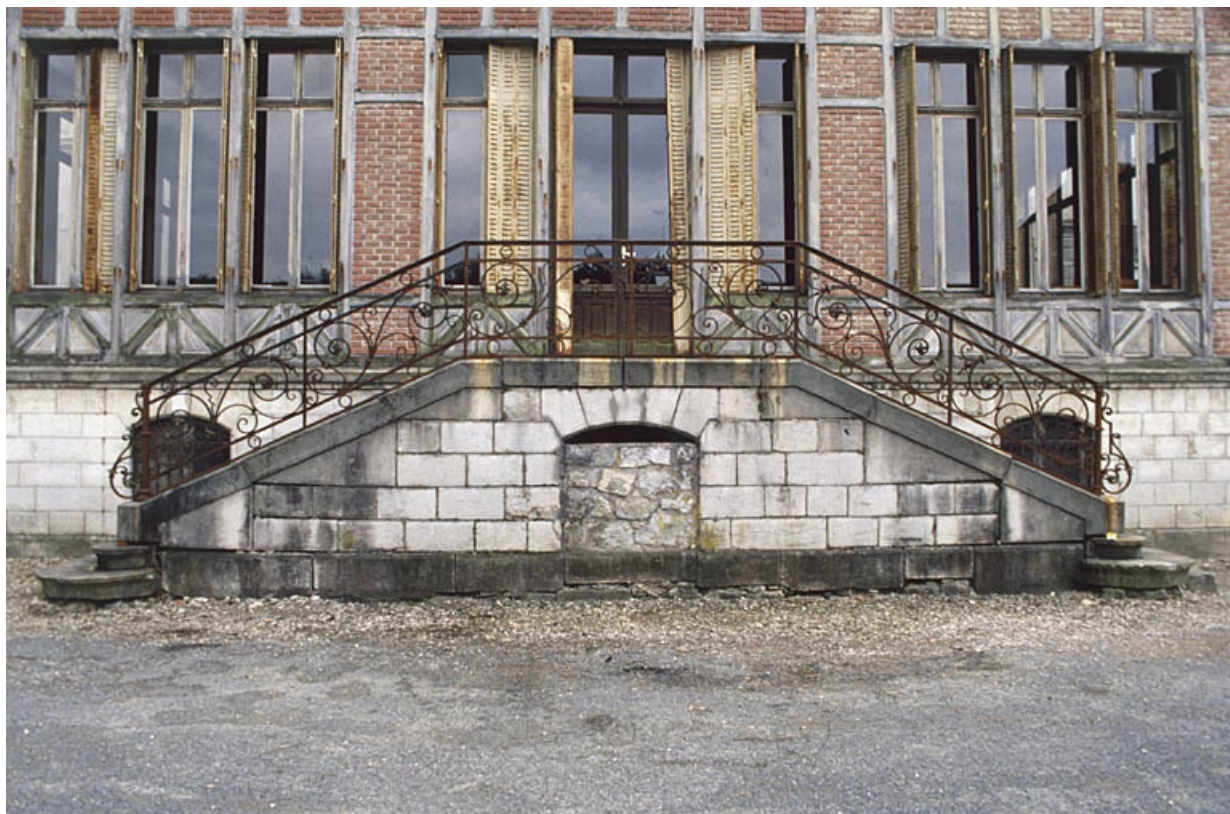
Escalier sur la façade postérieure.
