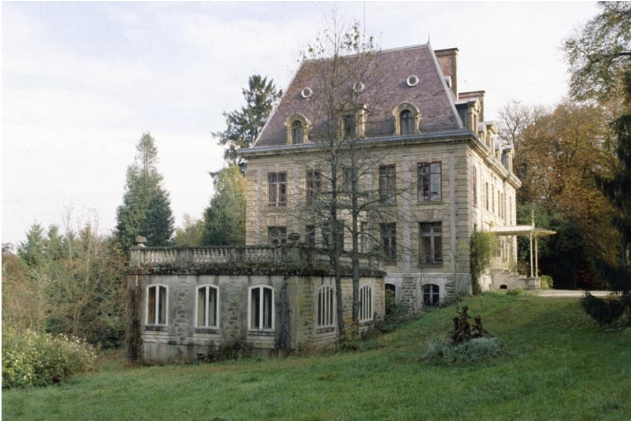
Vue depuis l'ouest.
