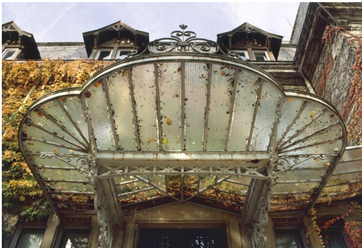
Marquise de la façade sud.
