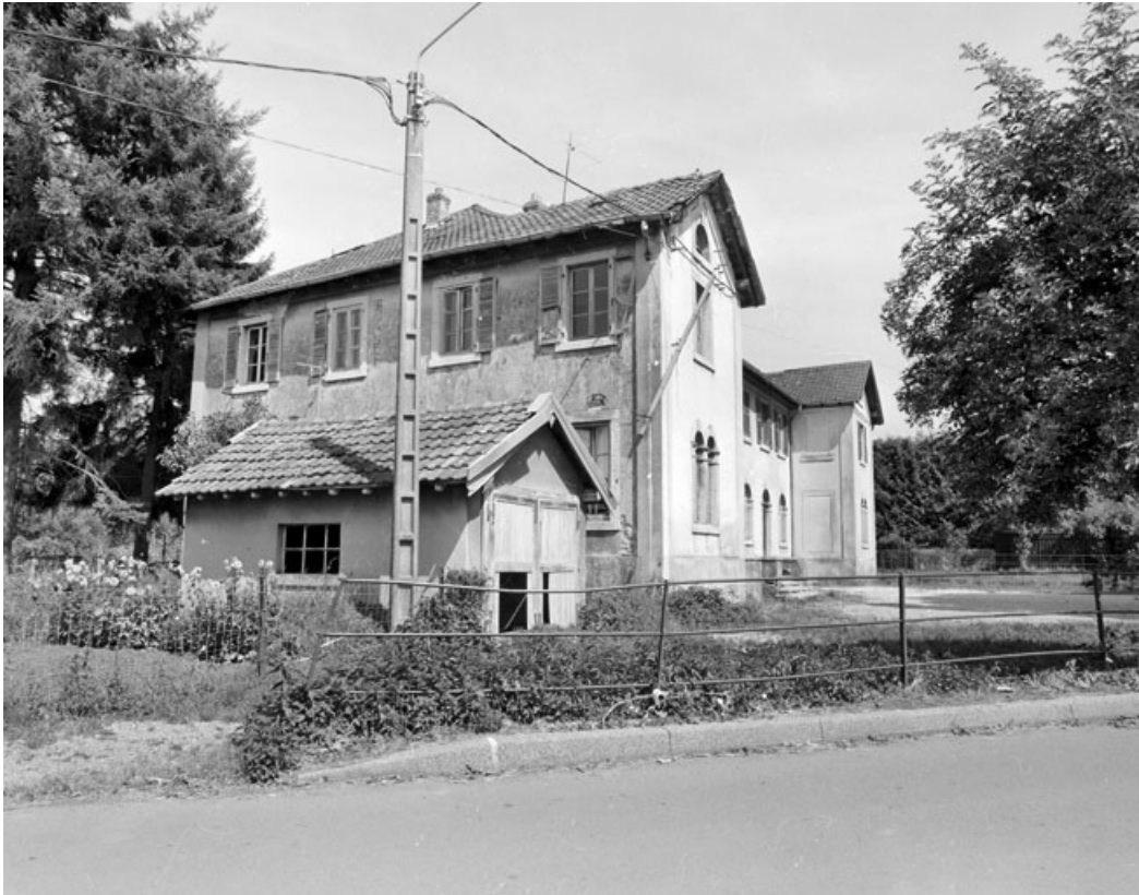
Elévation depuis l'ouest.
