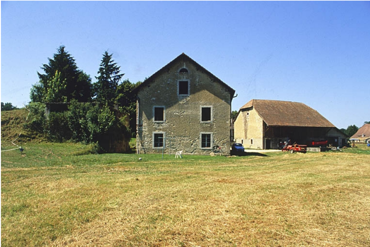
Mur-pignon nord du moulin.
