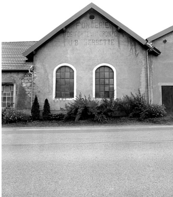
Mur-pignon d'un atelier de fabrication.
