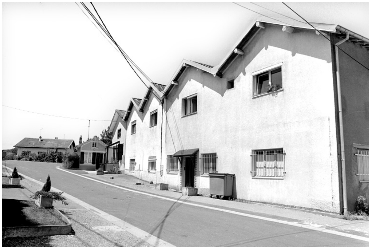
Murs-pignons des ateliers de fabrication.
