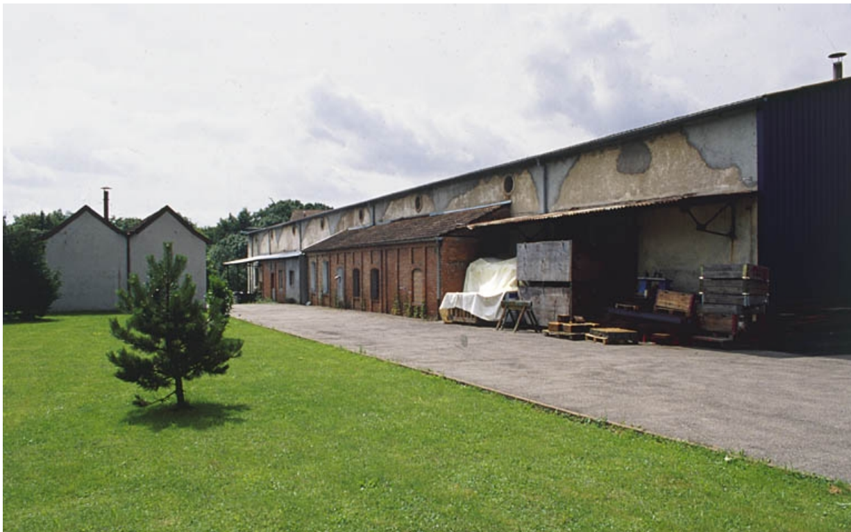
Façade postérieure des ateliers de fabrication.
